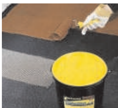
Vrchní krycí nátěr. Gumoasfalt SA 23, nanášení válečkem.
