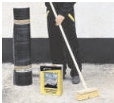
Před hydroizolací je třeba povrch důkladně očistit.
