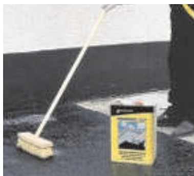
Penetrace pomocí pokrývačského kartáče.
