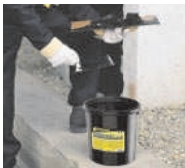
Po důkladném promíchání práškového tužidla (složka B) s asfaltovou hmotou (složka A) je materiál připraven k nanášení.
