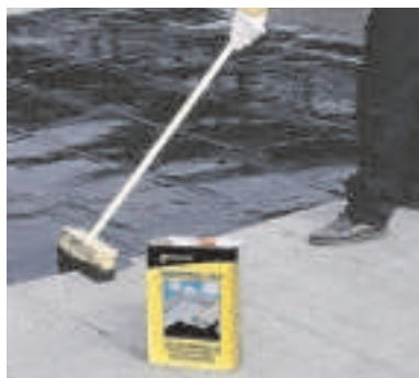
Obnovovací nátěr na staré krytiny Penetrale ALP.
