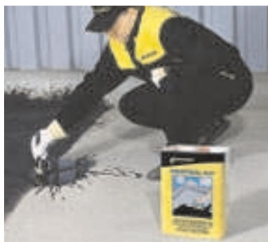
Penetrace betonu nátěrem Penetral ALP.
