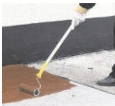
Aplikace SA 23 pomocí válečku.
