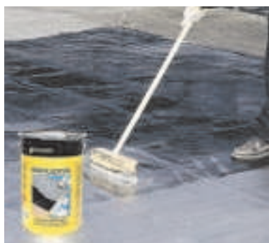
Vrchní nátěr asfaltolinikovým lakem Reflexol.
