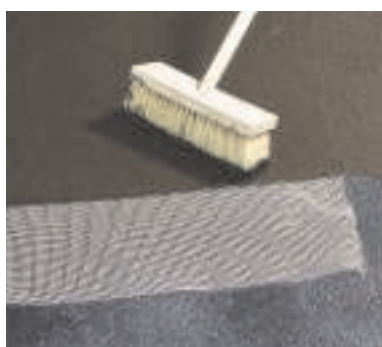
Na skelnou tkaninu se SA 12 aplikuje pomocí pokrývačského kartáče nebo válečkem.
