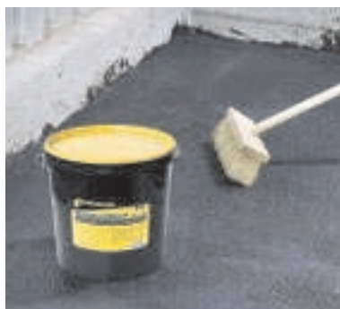
Gumoasfalt SA 12 se na penetrovaný beton nanáší pomocí pokrývačského kartáče nebo štětce.
